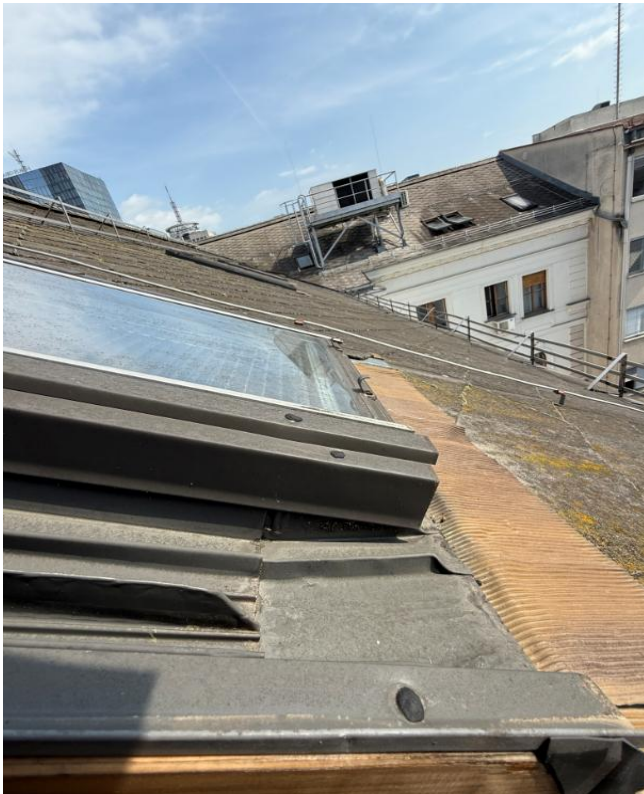
Slika 4: dotrajana strešna okna v mansardi
