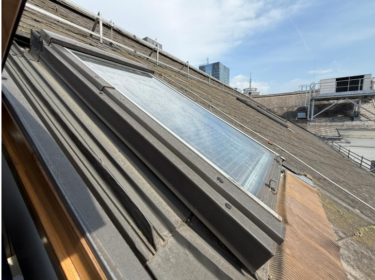
Slika 3: dotrajana strešna okna v mansardi
