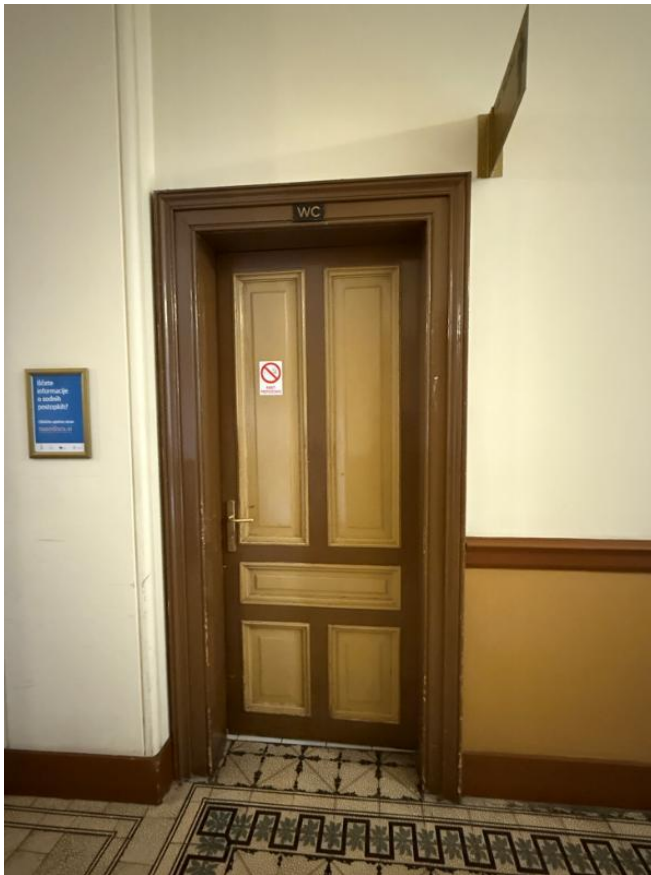
Slika 5: vhodna vrata obstoječih sanitarij v pritličju
